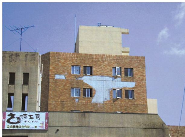
図 8.2 タイル仕上げの大規模な剥落
